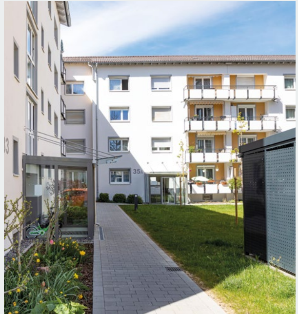
Modernisierte Gebäude in Pforzheim.
